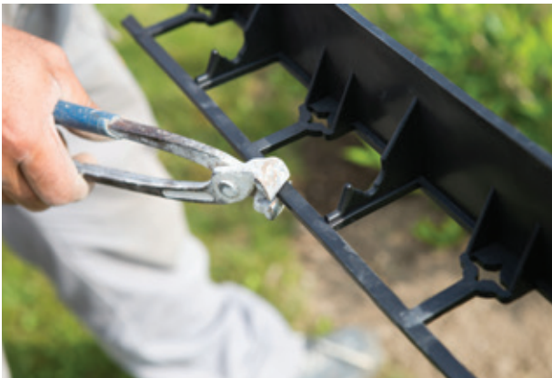
REZANJE VANJSKIH PREČKI
